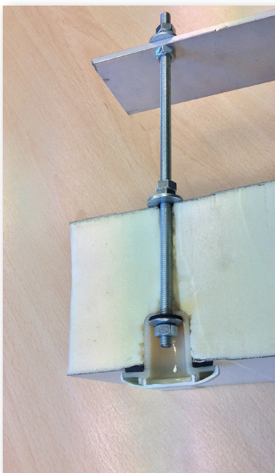
Sospensione del pannello di soffitto tramite asta filettata fissata direttamente alla struttura
